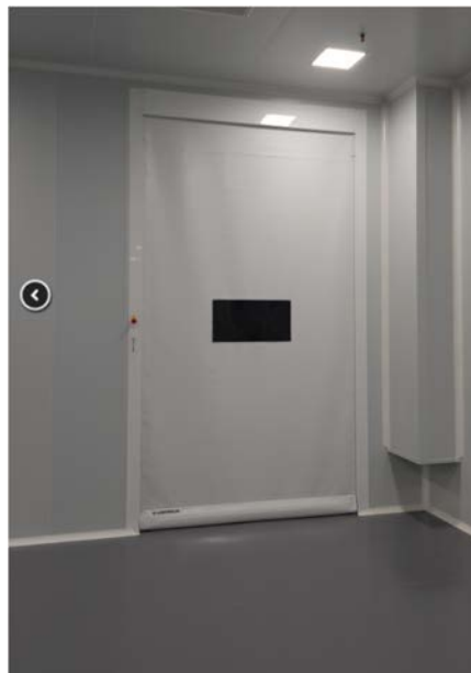
Puerta rápida sala blanca Clean room quick door
